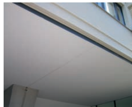
Abdichten im Aussenbereich
