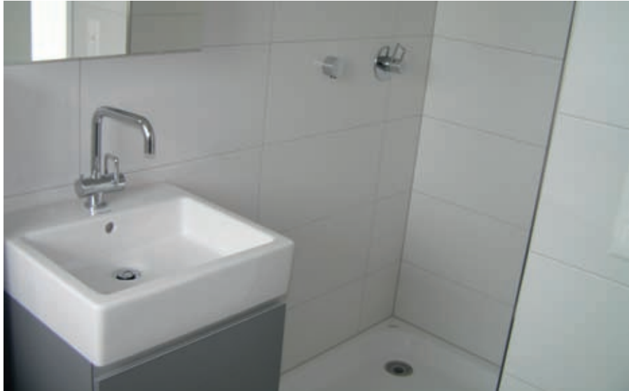
Abdichten im Sanitärbereich
